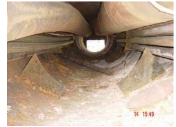
สภาพท่อไอน้ำใหญ่ที่ฉีกขาดบริเวณรอยเชื่อมยึด ผนังหน้าและผนังหลัง
